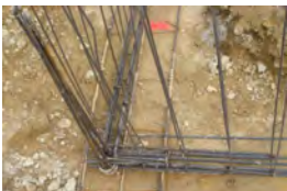
Nœud de chaînage - Continuité mécanique
