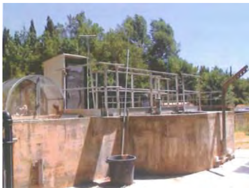
Prétraitement et dispositif de prélèvement « entrée de station »-Source : ARPE Synthèse annuelle des résultats d'auto-surveillance 2013
