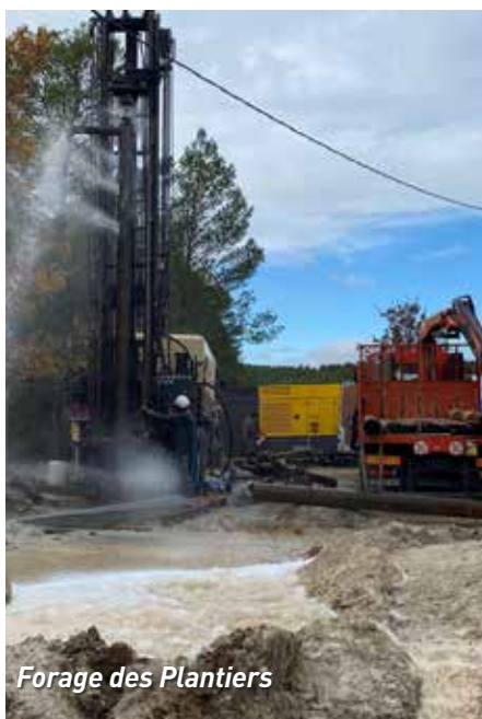
Forage des Plantiers
